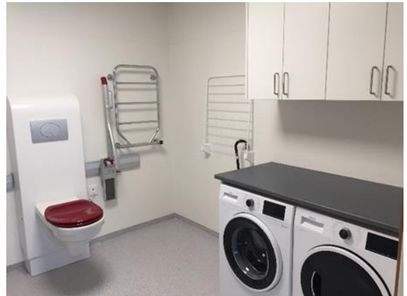
Bild nr 14 Del av badrum, toalett, tvätt/torktumlare
