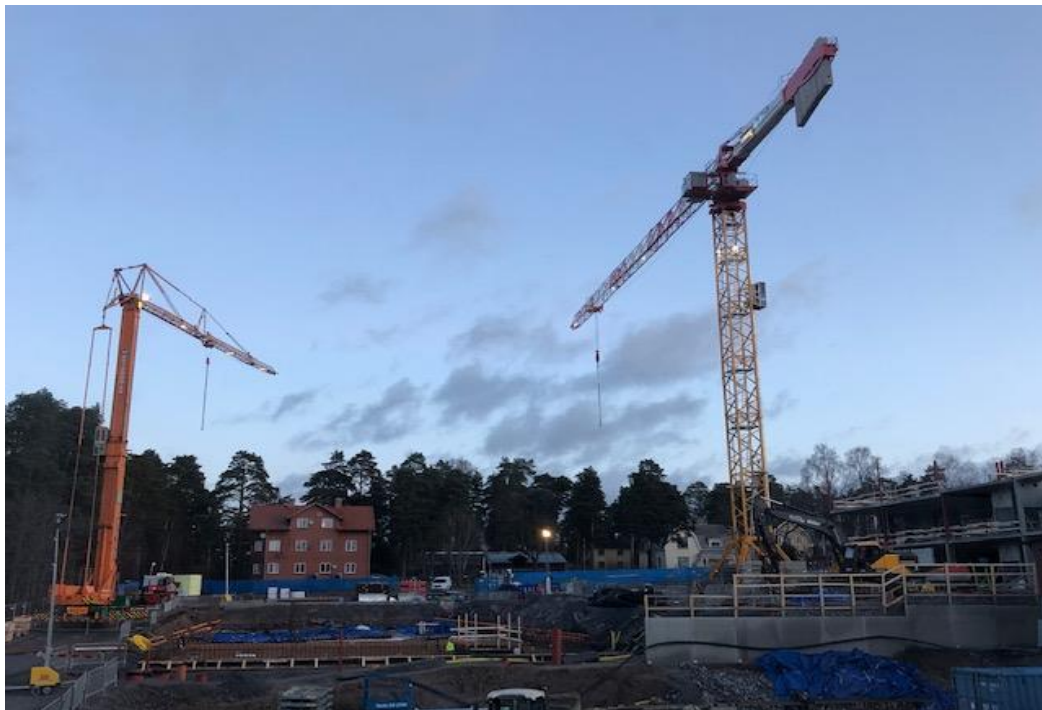
Dubbla kranar igång på Kv Hjorten
