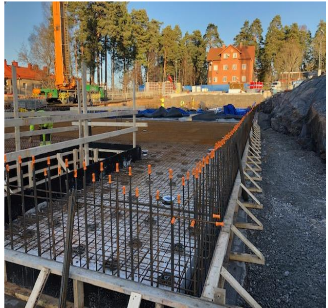
Hus 2, formning av källarväggar samt armering av bottenplattan innan gjutning.
