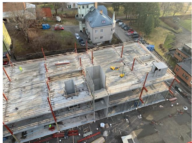
Prefab fortgår på Hus 4.
