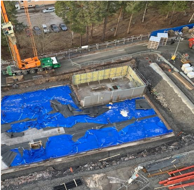
Hus 2, formning av källarväggar samt armering av bottenplattan innan gjutning.
