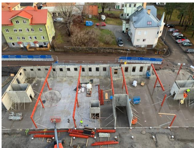
Stålmontage igång på Hus 4
