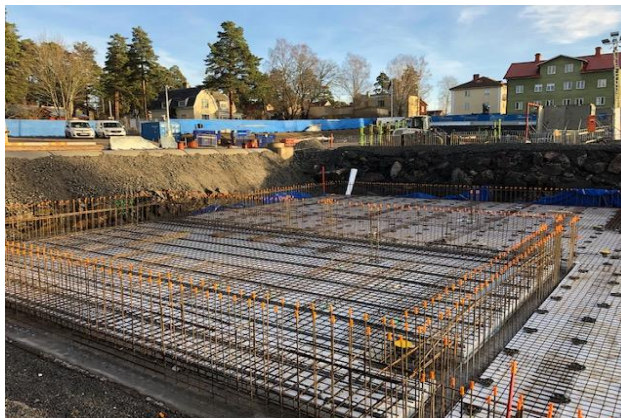
Armering platta och väggstick i Hus 2 för skyddsrum
