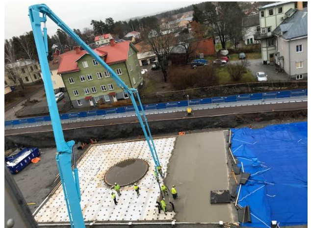
Gjutning av bottenplattan i Hus 4 förra veckan. V 48.
