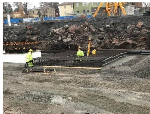
Grundarbeten fortlöper som planerat i Hus 2
