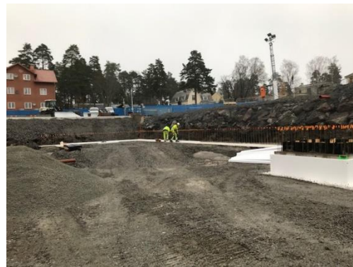
Grundarbeten fortlöper som planerat i Hus 2
