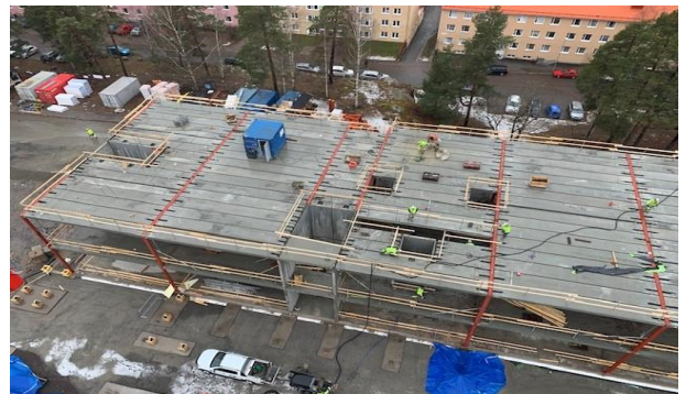
Prefabmontaget på Hus 2 fortlöper som planerat.
