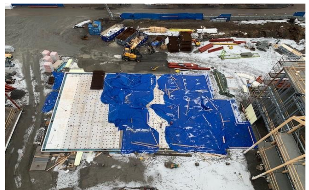
Bottenplattan på Hus 3 skrider framåt
