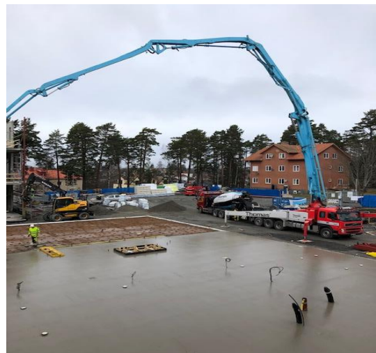
Gjutning av bottenplattan på Hus 3
