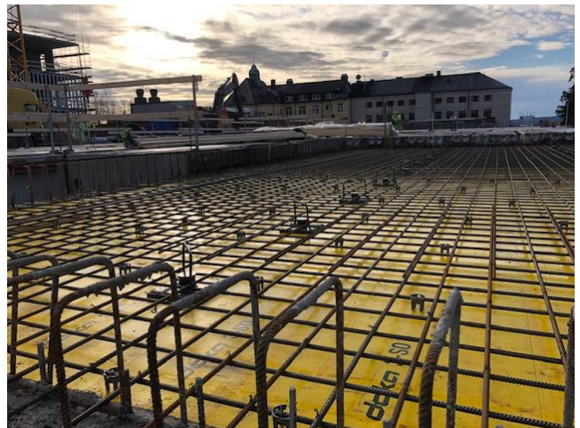
Skyddsrumsbjälklagets armering påbörjad i Hus 2.
