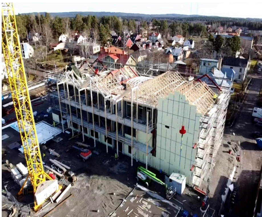
Hus 4 ifrån drönare av Lärkängens Bygg & Entreprenad
