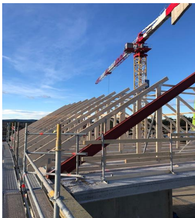
Takstolsmontage igång på Hus 4
