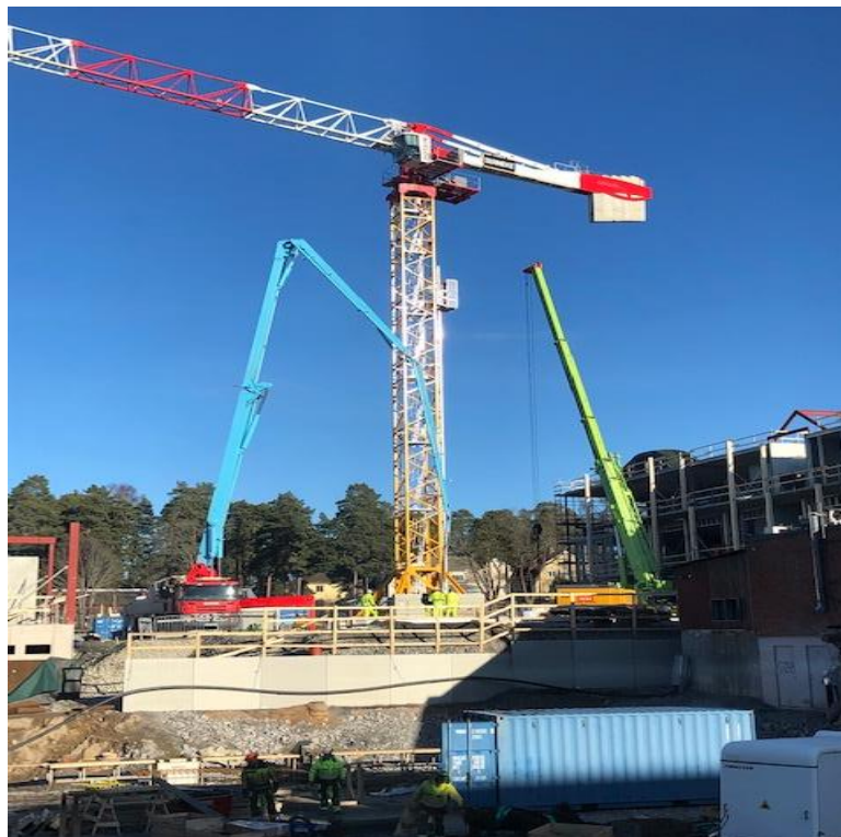
Gjutning bottenplatta Hus 1
