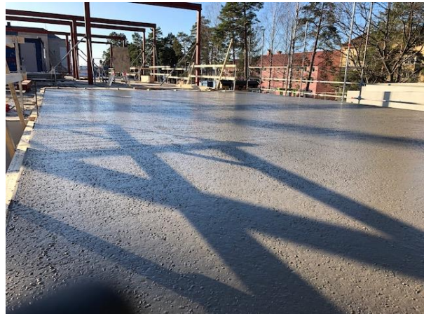
Skyddsrumsbjälklag Hus 4 färdig gjutet
