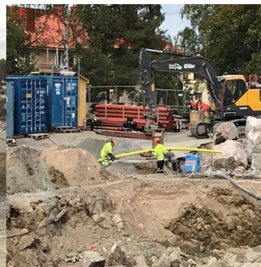
Läggning av byggström
