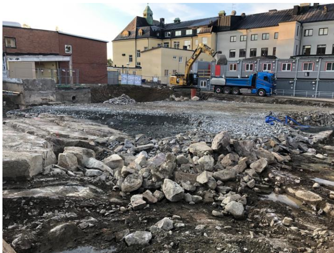
Markarbeten fortlöper för matsalen och Hus 5
