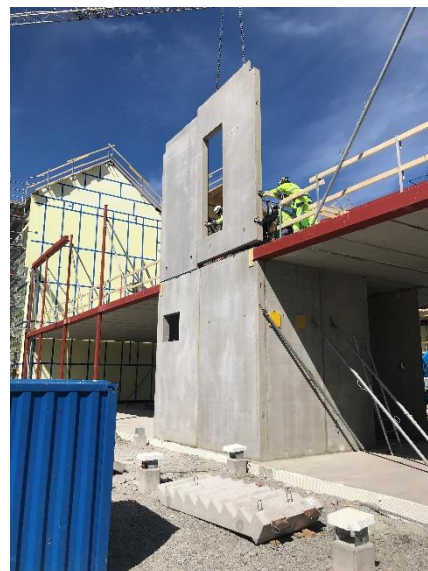
Montage av trapphusvägg Hus 1
