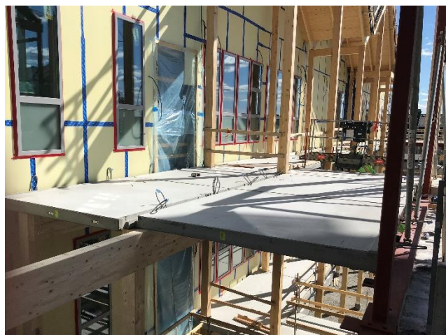
Loftgång mellan Hus 3 och Hus 4
