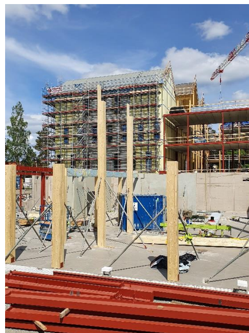
Foto taget från bodetablering mot matsalen, Hus 2 och Hus 1
