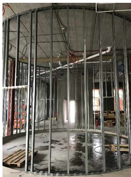
Nu börjar innerväggar ta form i särskolan. Rörelserummet som är ett runt rum visas på foto.
