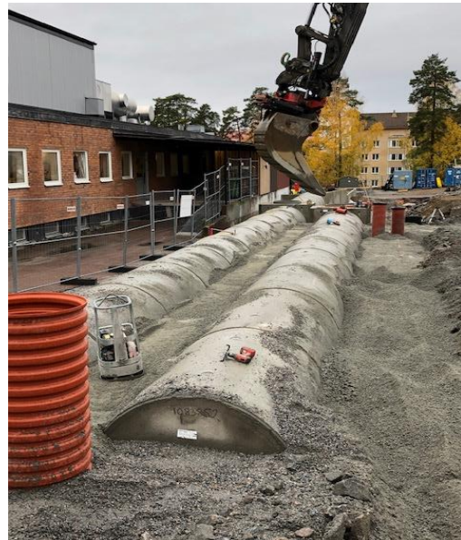
Dagvattenmagasin vid Hus 1 monterat
