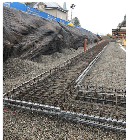
Grundarbeten i Hus 4 påbörjat
