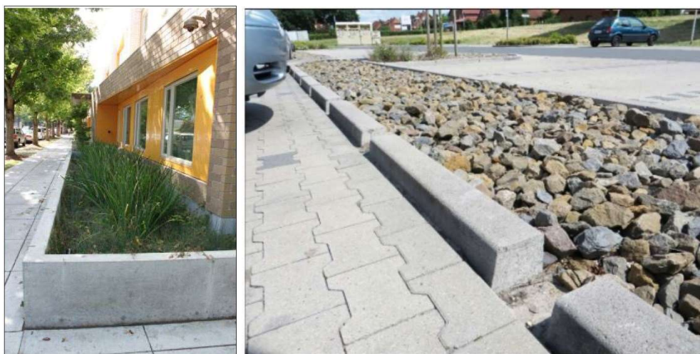
Bild 13 och 14: Regnbädd som tar hand om dagvatten från tak (Stockholm Vatten och avfall & Svenskt Vatten Utveckling) respektive makadamdike vid parkering.
