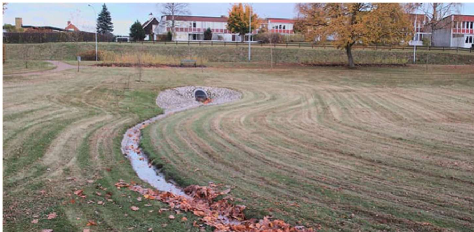
Bild 15. Exempel på torrdamm (Stockholm Vatten och avfall)
