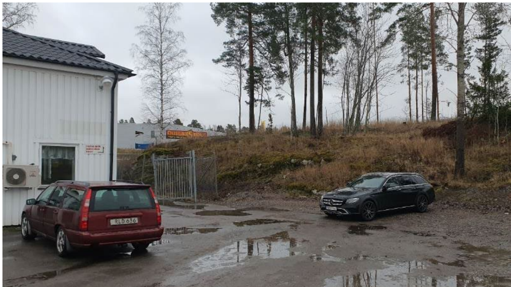
Skärning med morän och berg vid kullen i södra delen av planområdet.
