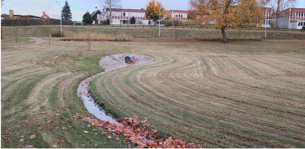
Figur 15 Exempelbild av torrdamm (foto: Stockholm Vatten och Avfall)
