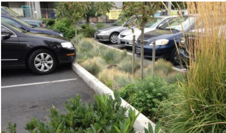
Figur 9. Biofilter som tar hand om dagvatten (Stockholm Vatten och Avfall, 2023).
